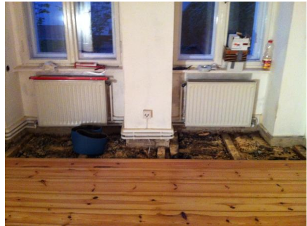
Blick ins Wohnzimmer – Reparatur des alten Dielenbodens
