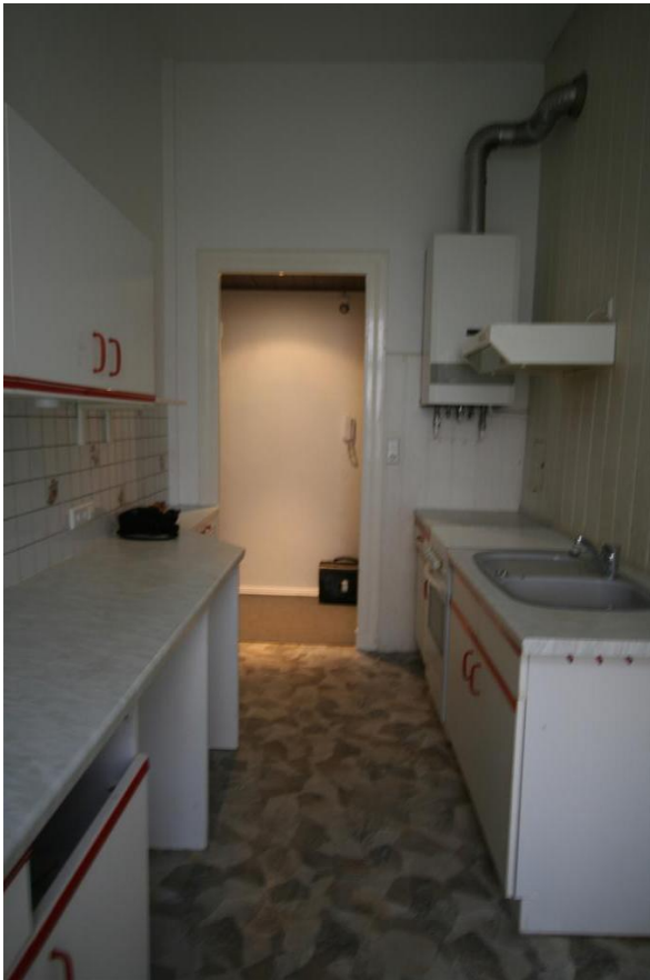
Blick in die Küche - Ursprungszustand
