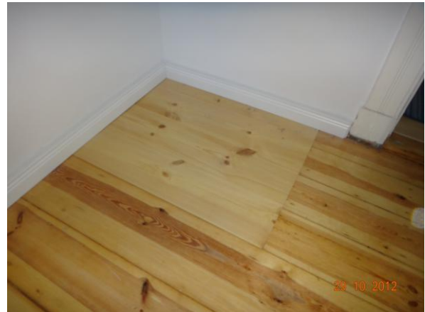
Blick ins Schlafzimmer – Reparatur der ursprünglichen Ofenfundamente
