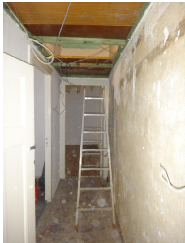
Blick in den Flur – während der Bauphase
