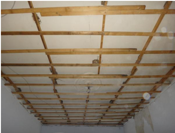
Blick ins Wohnzimmer – alte Decke
