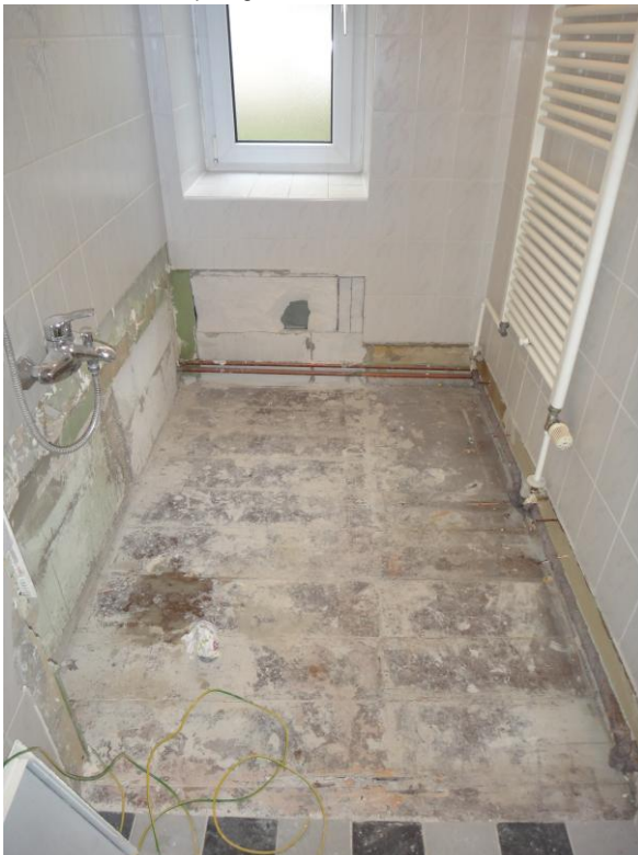
Blick ins Bad – während der Bauphase
