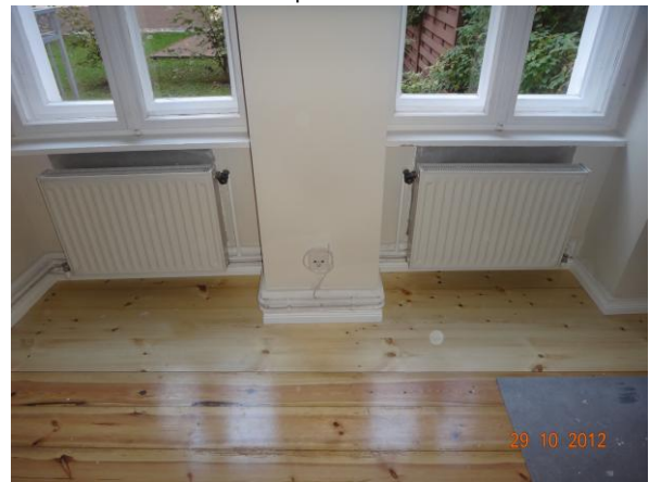
Blick ins Wohnzimmer – fertige Dielenboden
