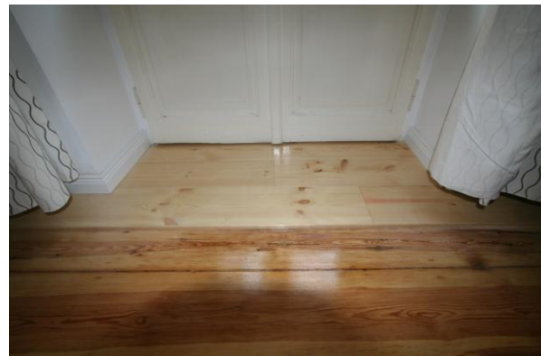
Blick ins Schlafzimmer – Abdeckung der Medien und Bau der Schwelle zur Terasse
