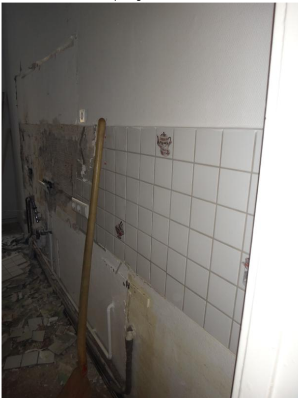
Blick in die Küche – während der Bauphase
